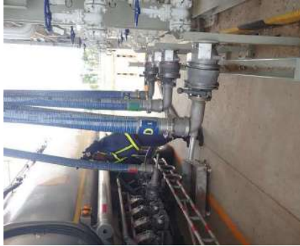
รูปแสดงการนำ Loading Arm มาต่อเข้ากับช่องรับน้ำมัน
