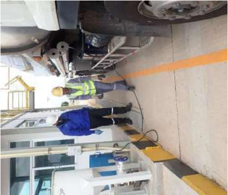
รูปแสดงการต่อสายกราฟต์ที่ Bottom Drain
