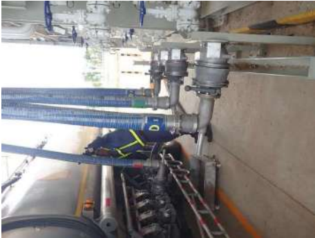
รูปแสดงการนำ Loading Arm มาต่อเข้ากับช่องรับน้ำมัน
